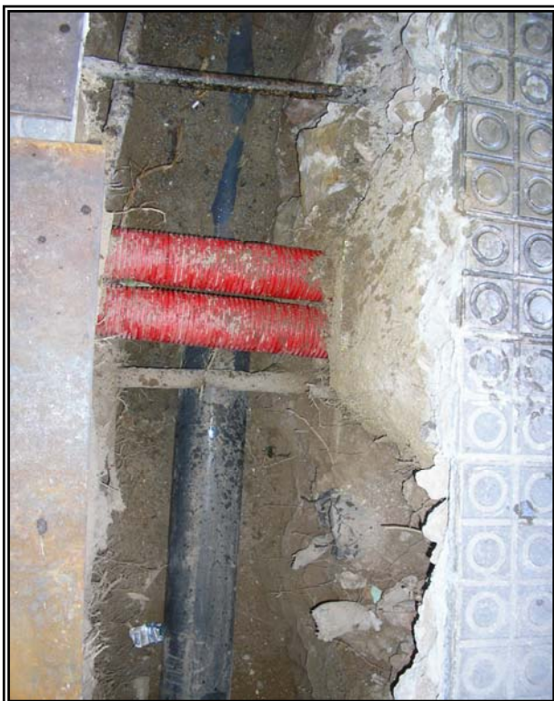
Canonada de desguàs Rasa 2
